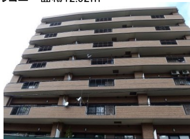
現地外観写真 現地(2019年4月)撮影
