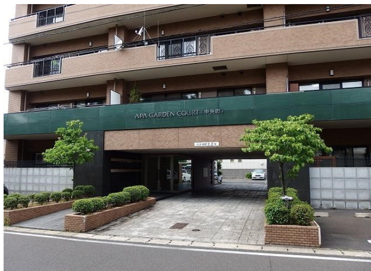
現地外観写真 現地(2019年4月)撮影
